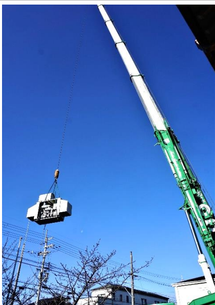
クレーンで宙に浮く自家発電機
